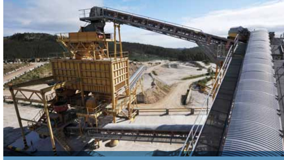
Canteira de áridos. Prebetong Áridos SLU. Xove (Lugo).
