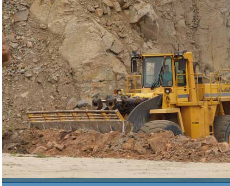
Canteira de áridos. Lista Granit SA. Arteixo (A Coruña).
